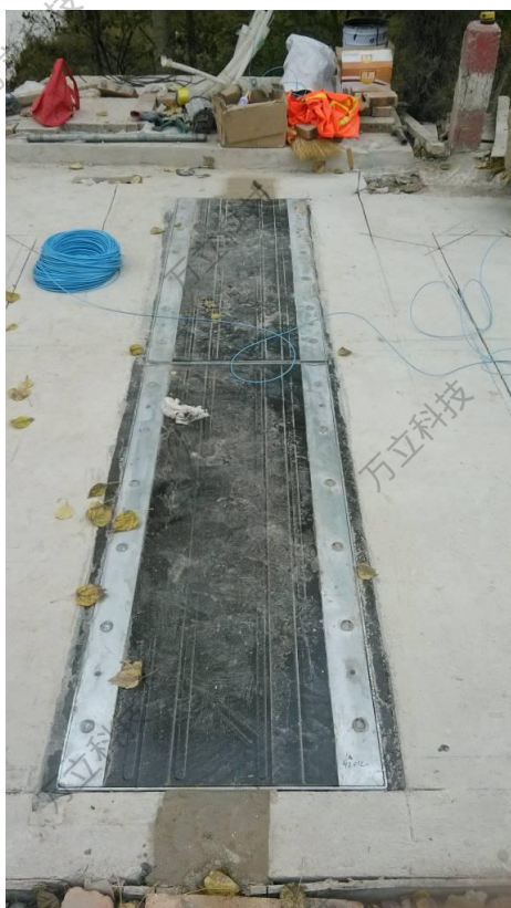
图 5-5 弯板称重秤台切缝
