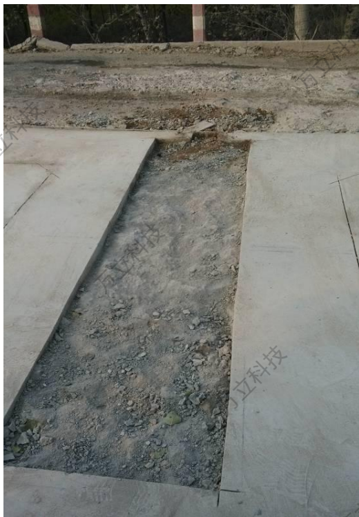
图 5-5 弯板称重秤台切缝
