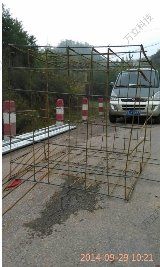
图 5-1 编制的钢筋笼
