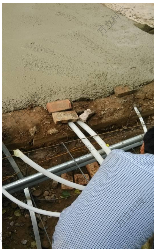
图 5-3 放置穿线管、钢筋笼、预埋件
