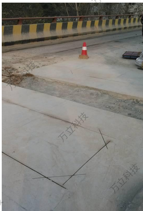
图 5-6 地感线圈切缝
